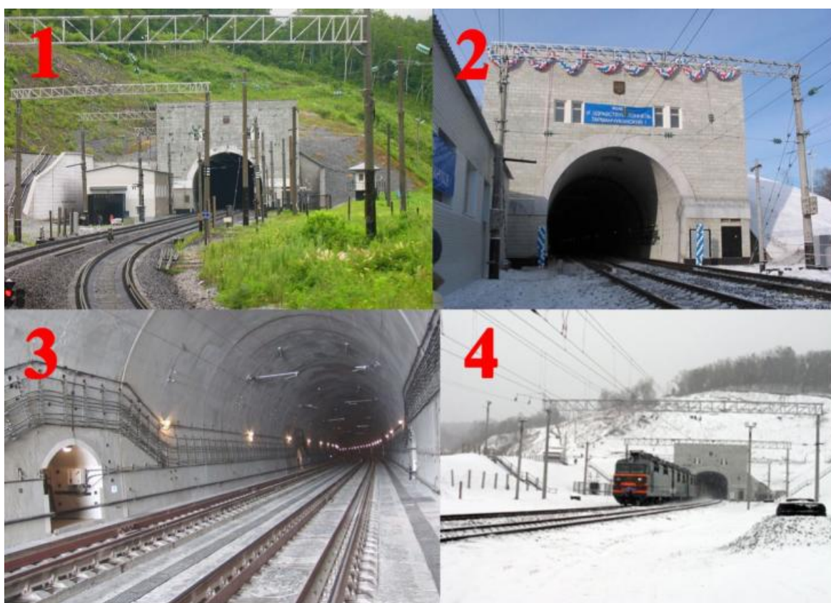
Рис. 8. Фотографии Тарманчуканского тоннеля: 1 – перед въездом в тоннель (юго-восток) [17] , 2 – въезд в тоннель (юго-восток) [18] , 3 – внутри тоннеля [19] , 4 – выезд из тоннеля (северо-запад) [20]
