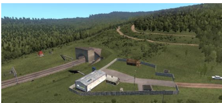
Рис. 13. Северо-западный въезд в тоннель (2)
